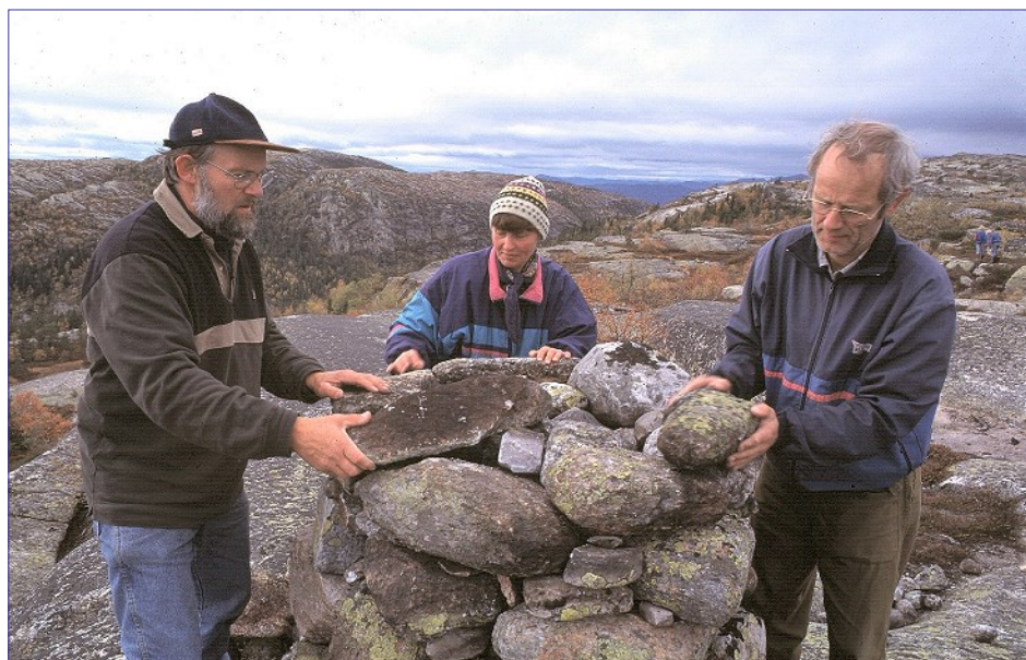
Bygging av turlagets jubileumsvarde. (Foto: Arne Hjeltnes)
